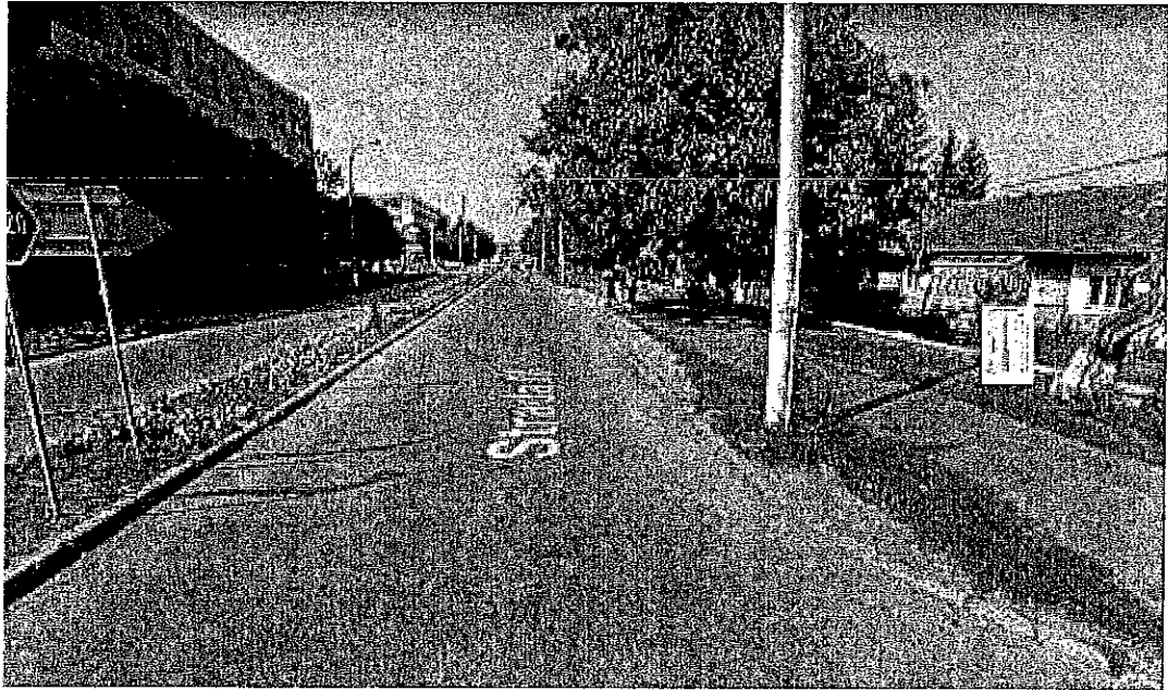
Foto 15. Intersecție str. Moldovei - str. Grădiniței. Amplasare automat semaforizare
