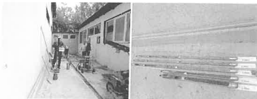
Foraj geotehnic – F01
