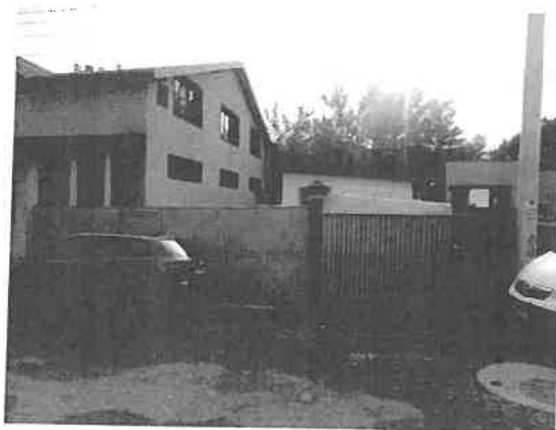
Fig. 9. Amplasament investigat geotehnic – situația existentă
