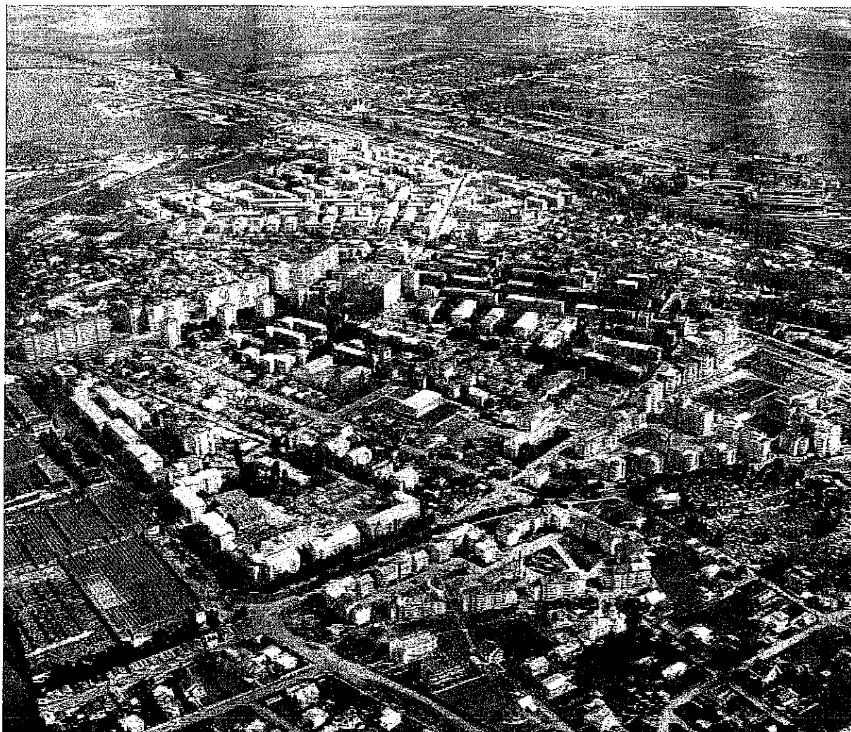
Fig. 1.1. Municipiul Pașcani – vedere aeriană
