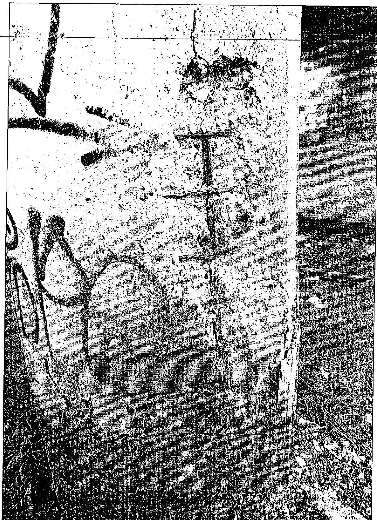
Foto. 9 – Degradarea betonului in elevația stâlpilor pilei
