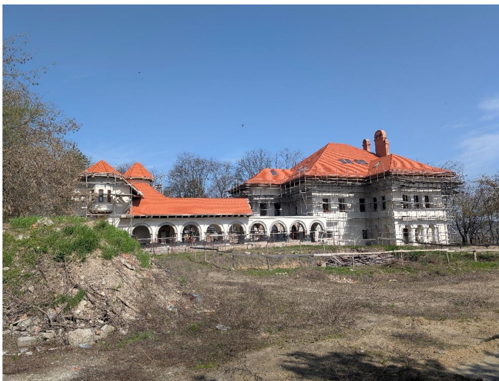
Figură 1 – Palatul familiei Cantacuzino-Pășcanu, lucrări de reabilitare
